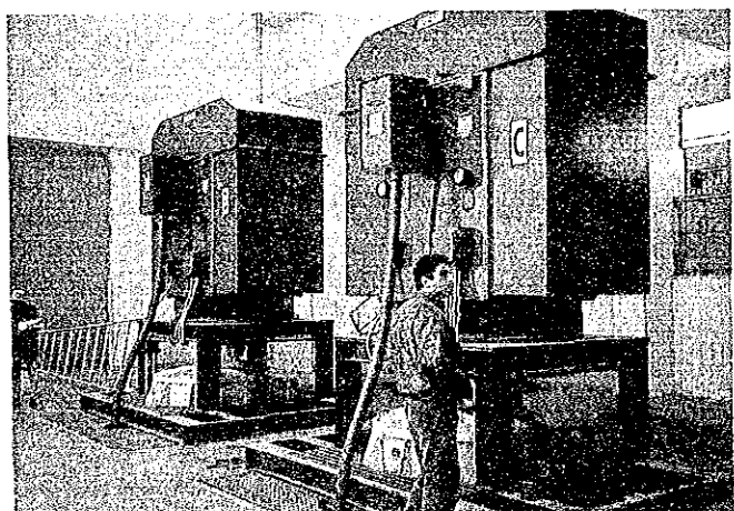
ヌバリヤ地区の揚水ポンプ場の内部 (エジプト)
