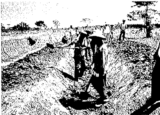
水路の掘削は農民グループ毎に範囲が割 り当てられる（キアエア村）
