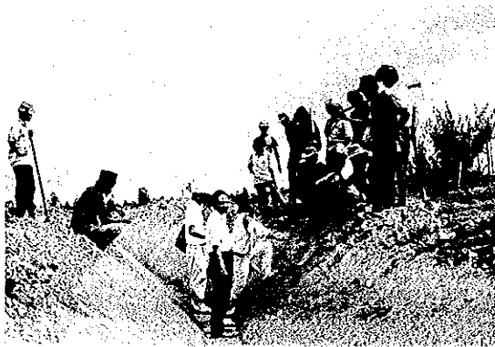
水路掘削後、専門家、C/Pと共に工事の 検査を行う（パランガ村）
