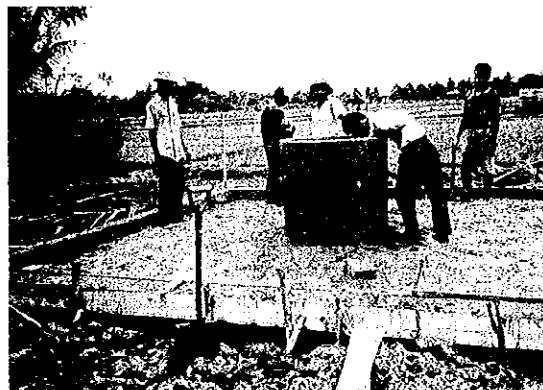
農民グループによる井戸の掘削工事 深さは5 m前後 (ラノメト村)
