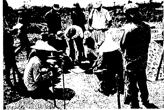
水路工事現場で打合せをする専門家、 C/P、農民たち（キアエア村）
