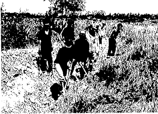
水路の掘削工事は農民グループが請負い 作業が進められる（ラノメト村）
