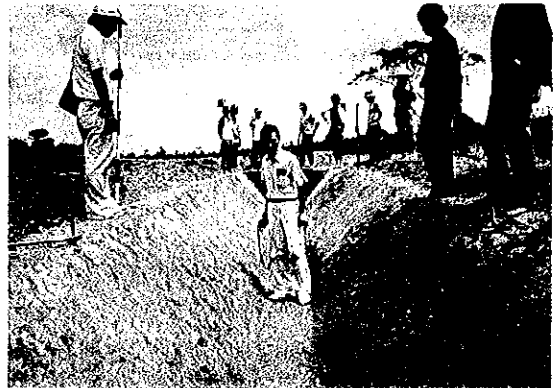
専門家による工事情況調査(キアエア村)
