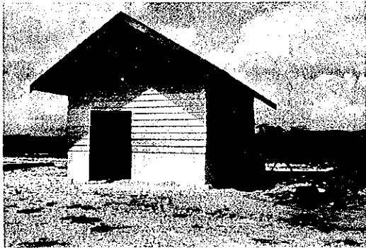
ラノメト村 精米施設（外部）
