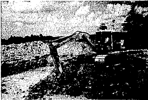
ラノメト村 B.Hによるミニため池の掘削
