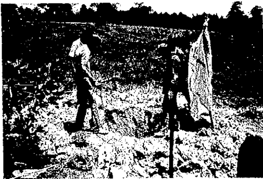
ラノメト村 共同井戸施工
