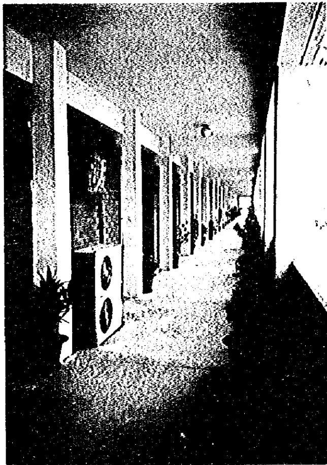
廊下に設置された スプリット型クーラー室外機
