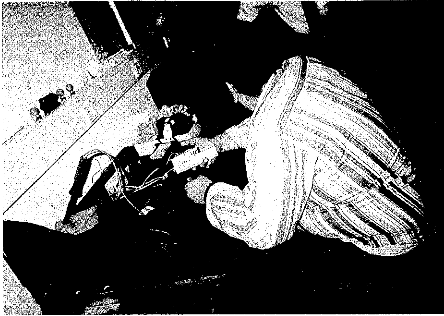
保健省所管シーファー病院セントラルワークショップメンテナンス 現場（ガザ地区）
