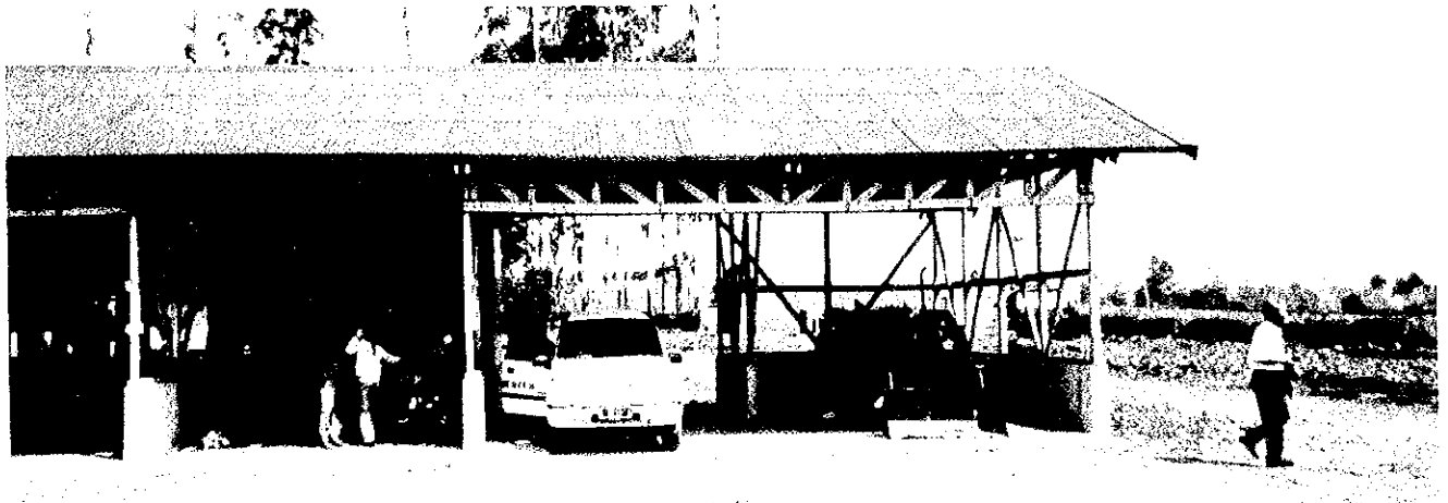
原種農場機材置場(日本側供与機材等)
