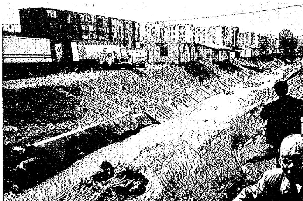
写真-4 ラナ排水路上流部護岸の破損状況
