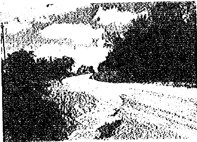
ミッドランド州の砂利道路肩に雑草が生い茂り、カーブの見通しが悪い。
