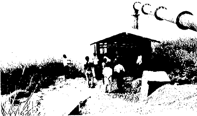
▲ アベイメ灌漑プロジェクト ディーゼルポンプ (軽油の供給が充分でなく、ほとんど使われていない)
