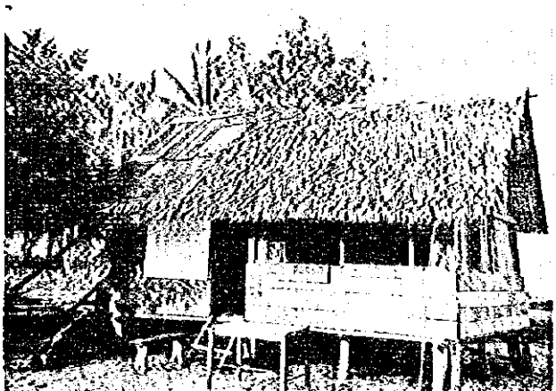
ワサニ村の災害救援所（POSKOと呼ばれるこのような救援所が各村に設置されている。）
