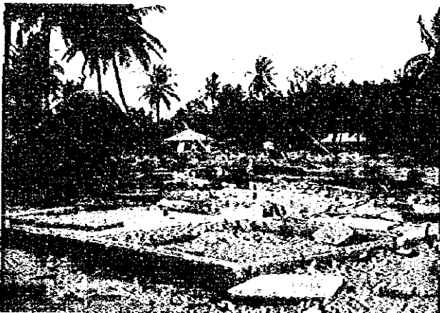
アンデイ村の、基礎のある組積造系の住宅の跡。基礎だ けが残る。
