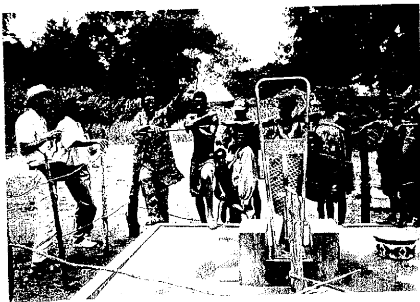
Etude d'échantillon dans un village: Pompe Vergnet pour puits dans le village d'Odokoto, département d'Ouémé. Elle fonctionne bien.
