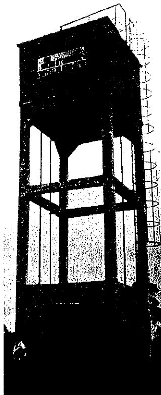
Etude d'échantillon dans un village: Petite adduction d'eau installée à la Phase III dans le village d'Agbanou, département Atlantique. (à droite: château d'eau, à gauche: borne fontaine). Elle fonctionne bien.
