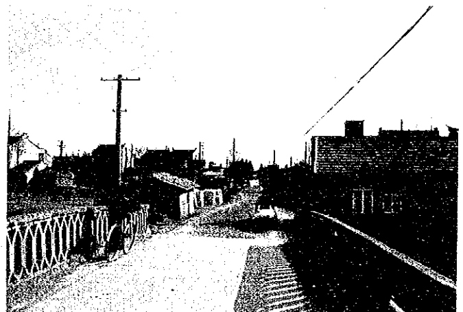
写真-10 新空港建設予定地 中心部 1
