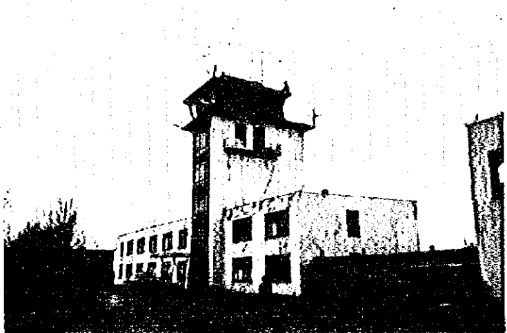
アクモラ空港 管制塔
