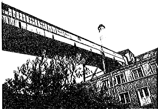
写真-15 ボルショド発電所運炭コンベア
