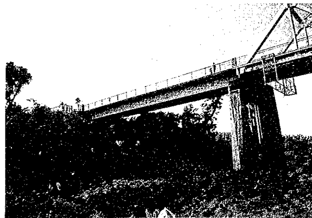
Culée, Pilier (Côté TOAMASINA)
