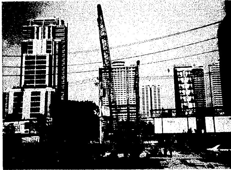
高層建築物の 建設現場
