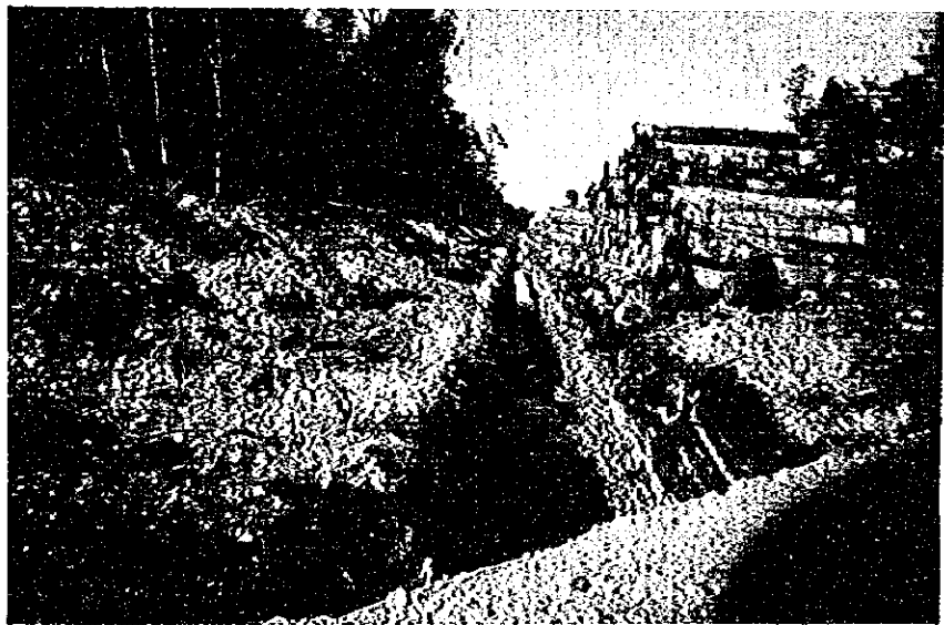
天然林伐採現場第X州 （ニャディ土壤のため排水路が作設されている）
