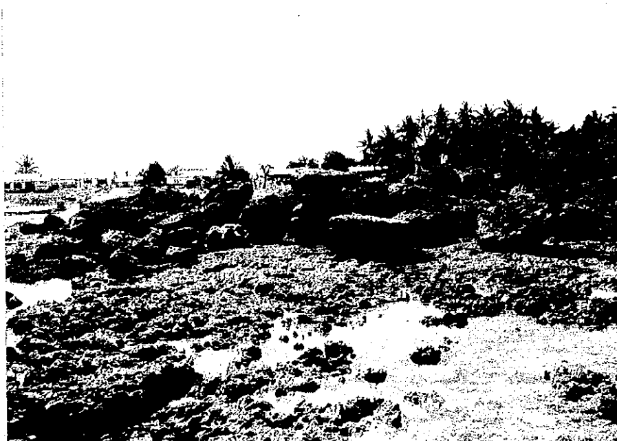
写真④ 南防砂堤先端付近被災状況
