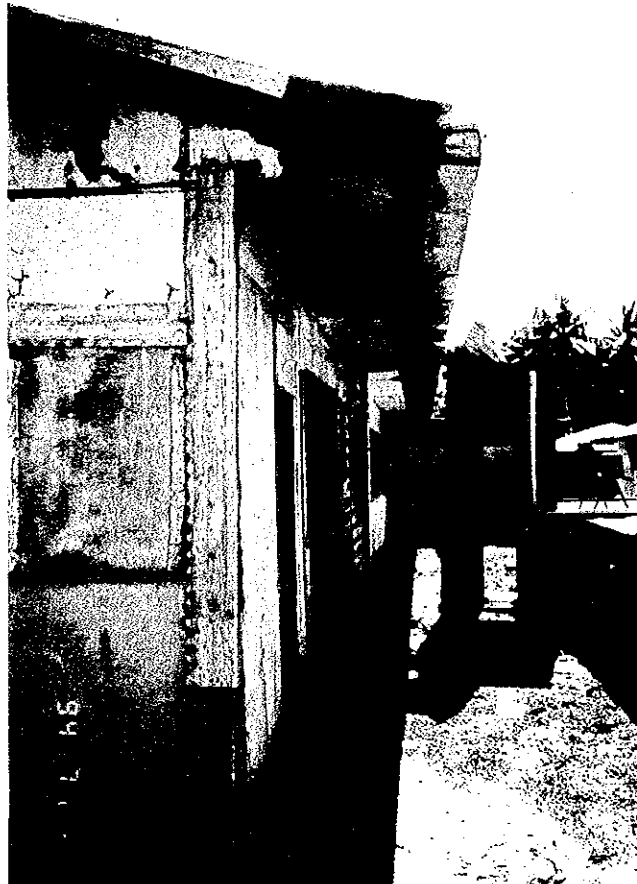
一般教室棟-1 (海側妻部壁 及びR9裏側軒天井
