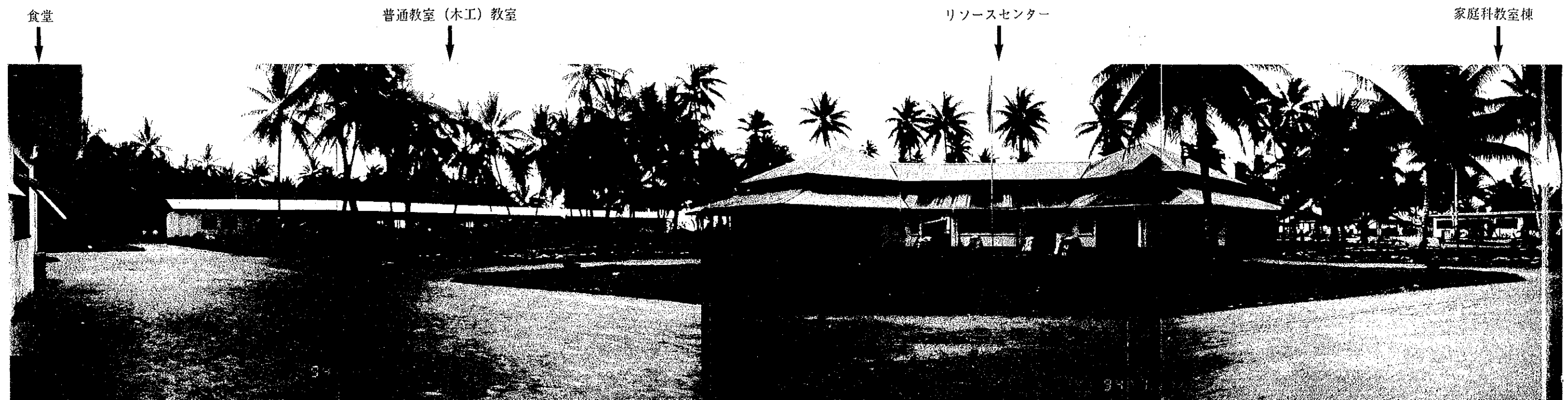
食堂前より、普通教室(木工)教室、リソースセンター、家庭科教室棟を望む
