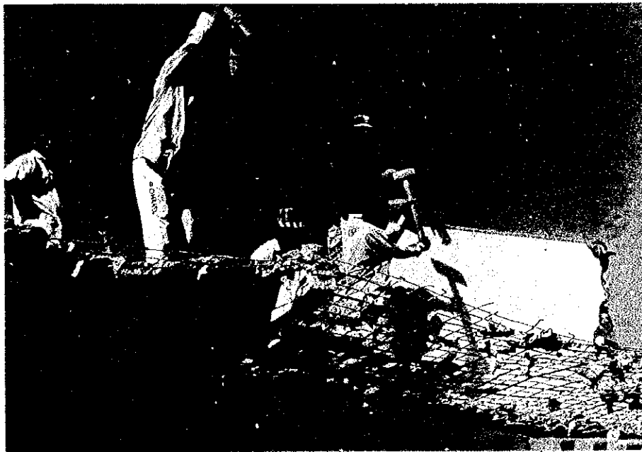
Demolition Work 解体中
