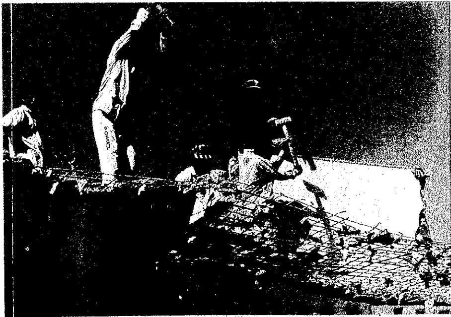
Demolition Work 解体中
