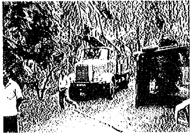
無償資金協力によるリグの現況(DR-5) 削井作業中を確認(利根TOP-200)
