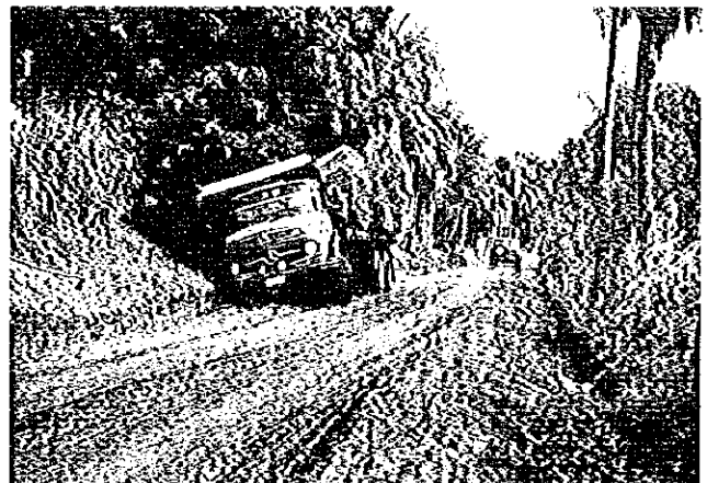
写真-30 Paraguari~Villarrica間道路のTebicuary~Villarrica間道路状況。この区間にはこの様な道路橋の狭い箇所がある。
