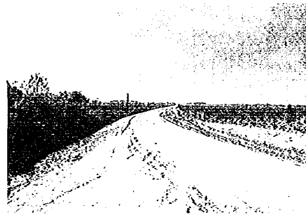
写真-23 Colonia Hector L. Vegaの町よりTebicuaryに向かって北上し、鉄道と再び並行する地点の道路状況。
