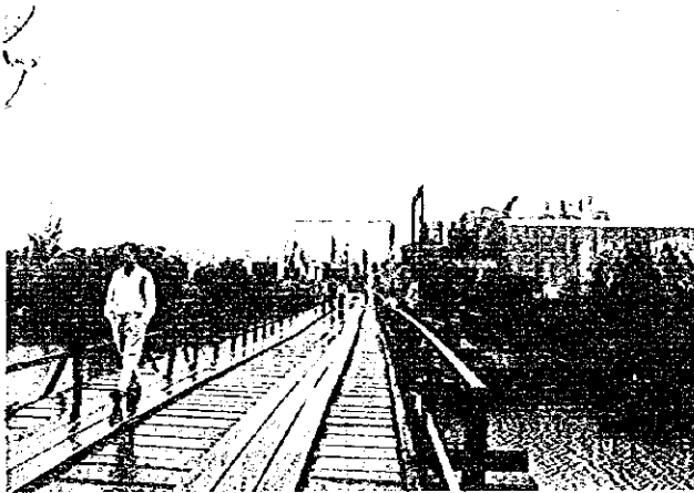
写真-27 Tebicuaryの町を流れるTebicuary Mi河に架かるParaguari~Villarrica間道路の道路橋。歩測で65mあった。洪水時は、水深が4.5m増す。
