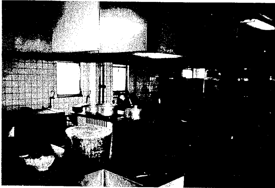
厨房機器とフード
