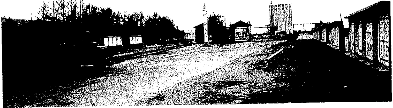
正面はトラックスケールの建屋、高い建物は飼料工場、正門へのアプローチ道路は整備されている（カラコルム）
