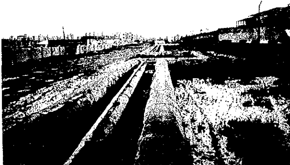
〔建設予定地（左側）への進入道路沿いに布設されている地域暖房用温水配管本管と工業用蒸気配管。〕
