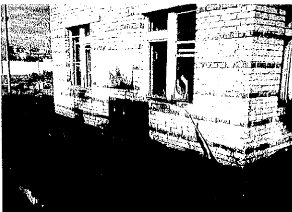
〔既設潤滑油給油場。屋外に給油口があり冬期の作業効率は低下する。〕
