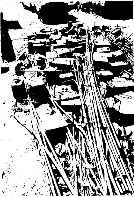
▲ 不許可接続地域。 箱はモーターポンプ。ここから動力で斜面上の家まで送っている
