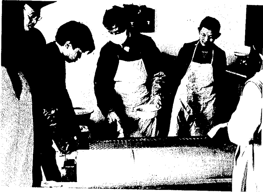
写真 3 - 7 ローラエポキシ樹脂塗布
