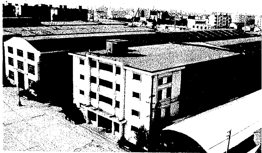
車両検査設備工場全景
