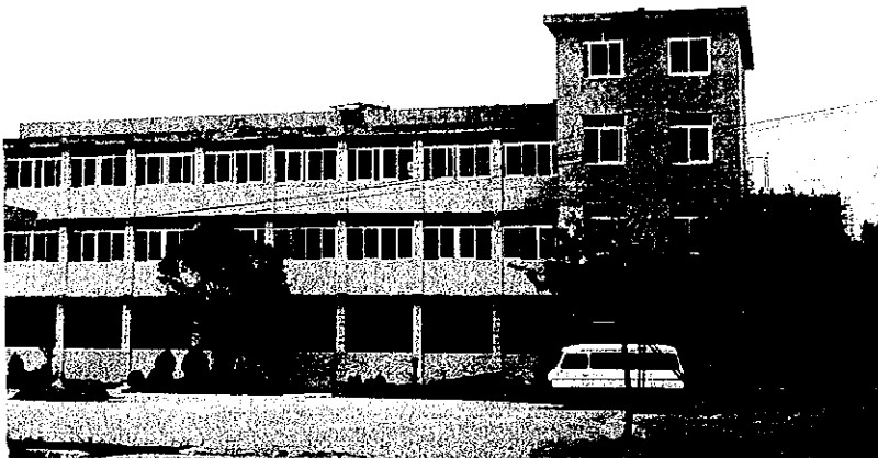
20. 改装中の湖北省種苗管理ステーション 新しい研究施設棟が建設されるまでは、ここが専門家活動の拠点となる。
