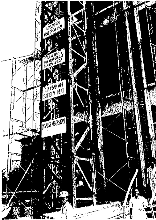
No.10 ジャカルタ市内の建設 現場のタワークレーン の脚部（安全標語を掲 示）
