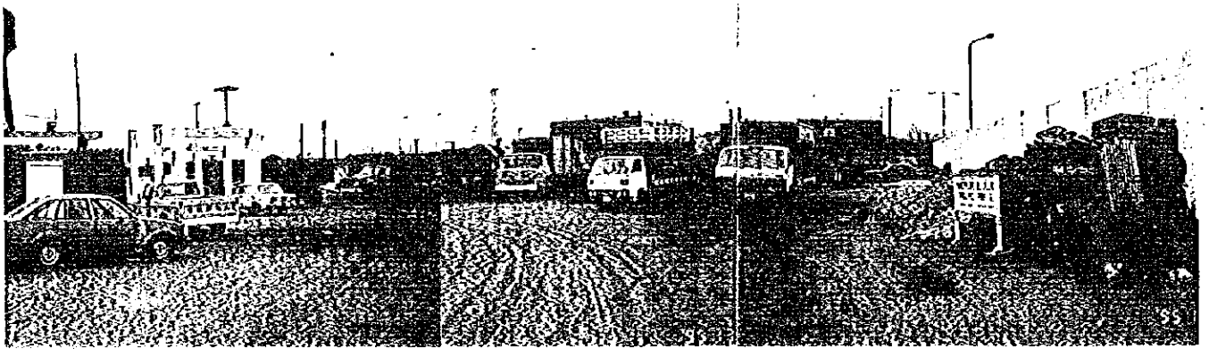
ESLIMP の新車輦基地兼整備工場の建設予定地 (大統領府の資金援助により、96年度の着工予定)
