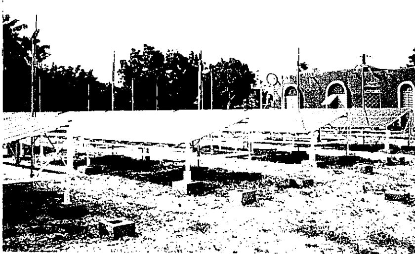
太陽光パネル ( 38W×560PANELS ) と蓄電池収納建屋 (オレンジ色の建物)
