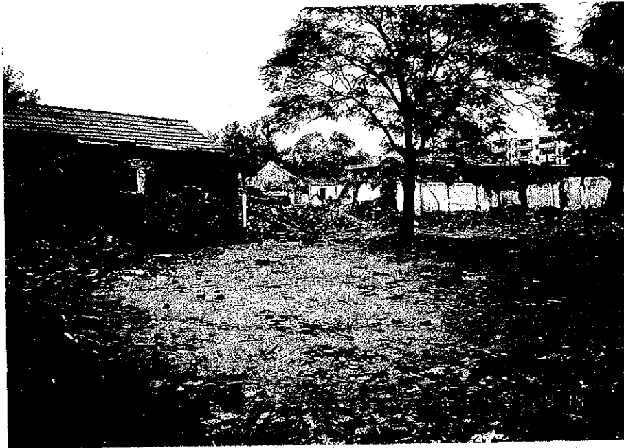
中国住宅新技術研究 人材育成センター 建設予定地
