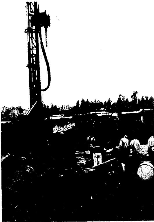
アディスアベバ南部郊外 井戸掘削現地-WWDE (93年度日本政府無償供与リ グ使用ロータリー型、DTH)
