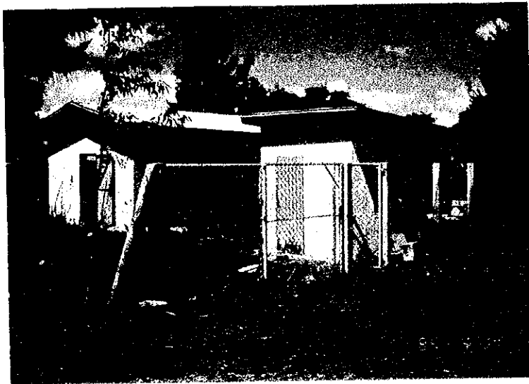
同上 管理棟及び塩素注入棟 (現在は塩素不足のため 機能していない)
