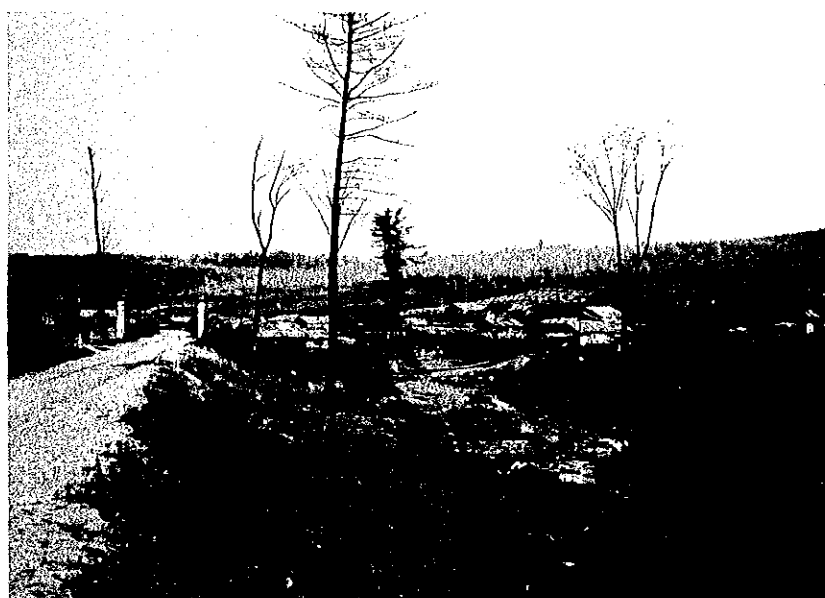
写真-12 二昆士 (ニコン)ダム上流サイトより下流部を望む
