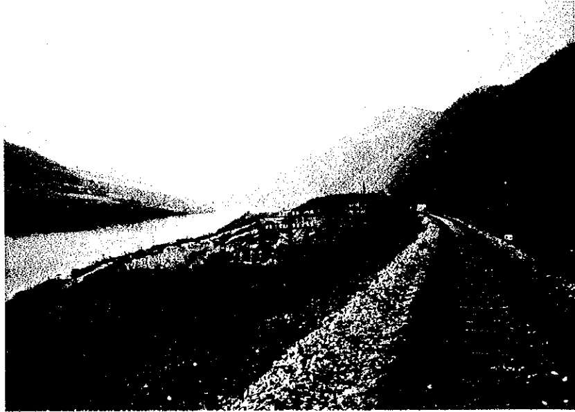
写真-17 興隆屯地点の放水口予定サイト
