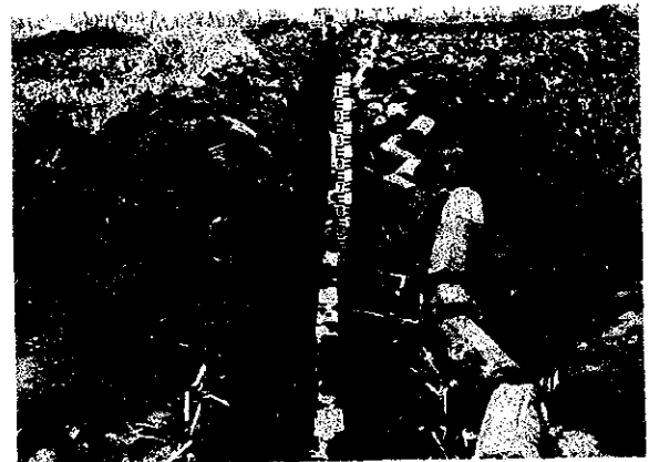
暗渠排水の施工写真 人力掘削、吸水管はコンクリート製 (「四湖在開発中先進」から)
