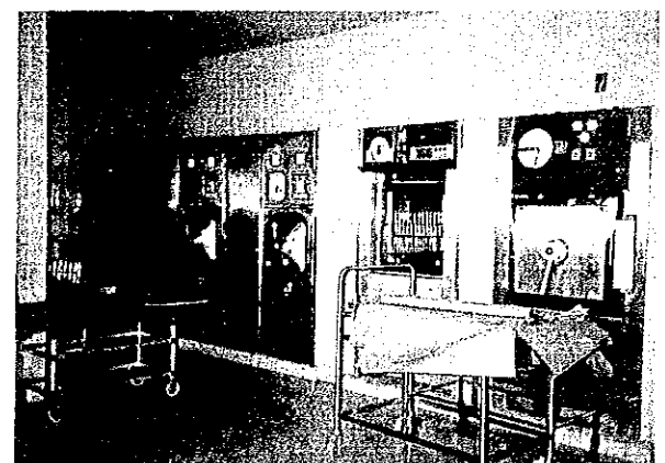
Centro de esterilización
