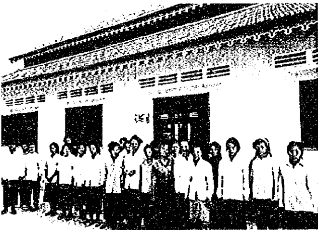
無償で建設されたWIDセンターと訓練受講生たち。 受講生が縫製と織物の訓練を受けていた。(コンボンスプー)
