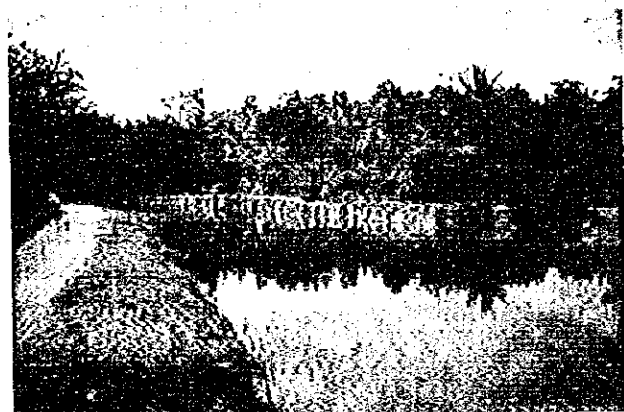
LB Main Canal (Sta.6+100)
