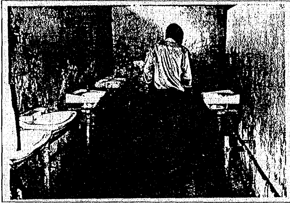
便所棟の手洗い ムンブエ地区中等学校 老朽化とメンテナンス不足から機能していない
