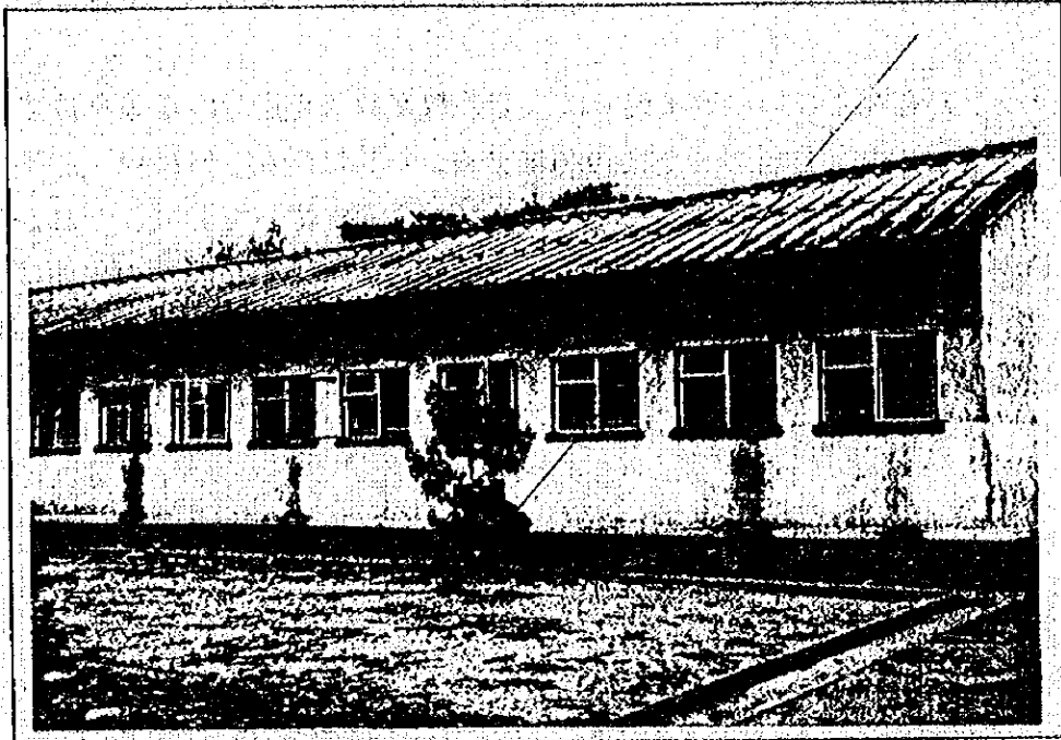
学生寮 ムンブエ地区中等学校 建物はかなり傷んでいる
