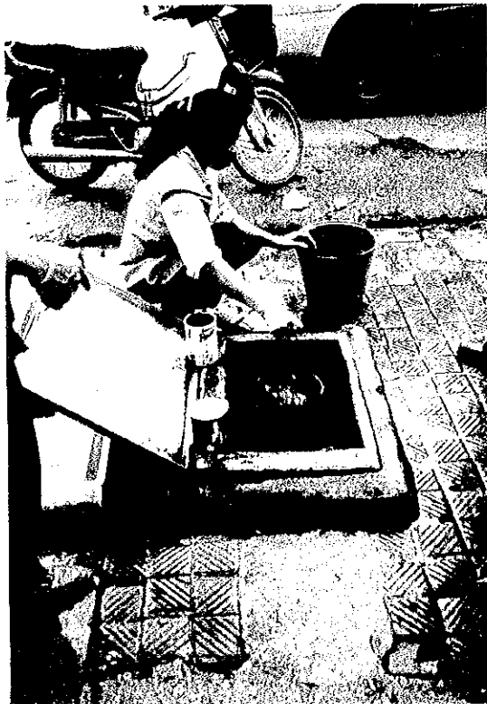
メーター箱のメーターを撤去し、 低水圧で流入する水道水を汲み上 げている。
