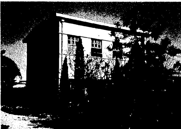
北京市高碑店污水处理場 移転予定地（既設建物状況）
