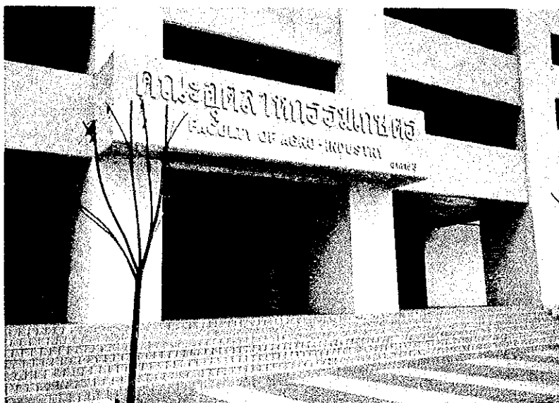
KAPIのある7階建ビル
