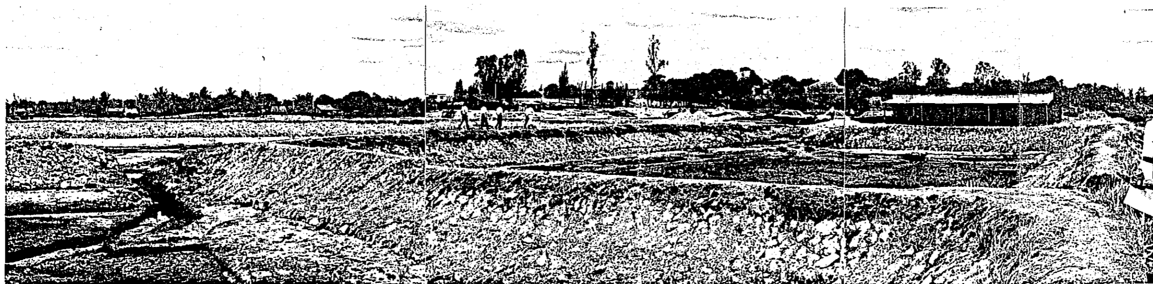
養成池（未完成、海側より）
