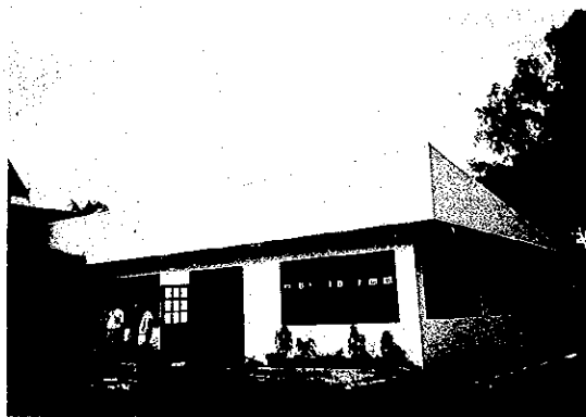
⑧ 建築中のMAF OFFICE外観
