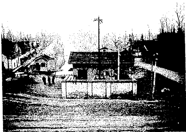
南大堤外部揚排水機場全景
