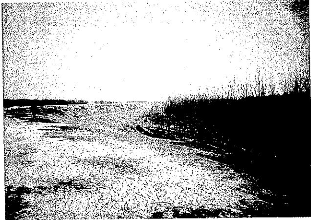
南大堤堤内、補強後の状況 (法面、法尻補強後、植林されている)
