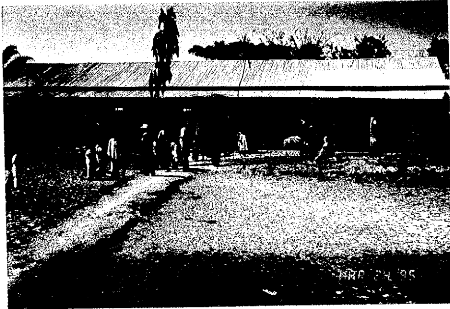
学校敷地全景
