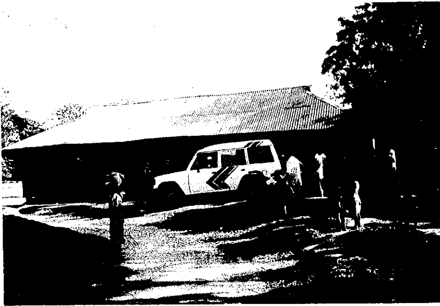
学校敷地全景
