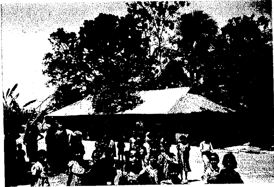
学校敷地全景
