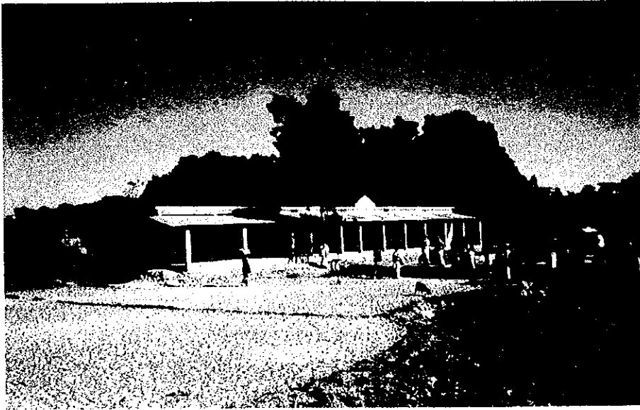
学校敷地全景
