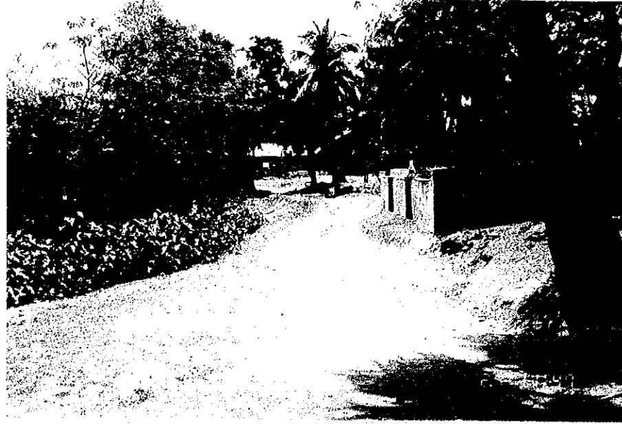
周辺の道路状況
