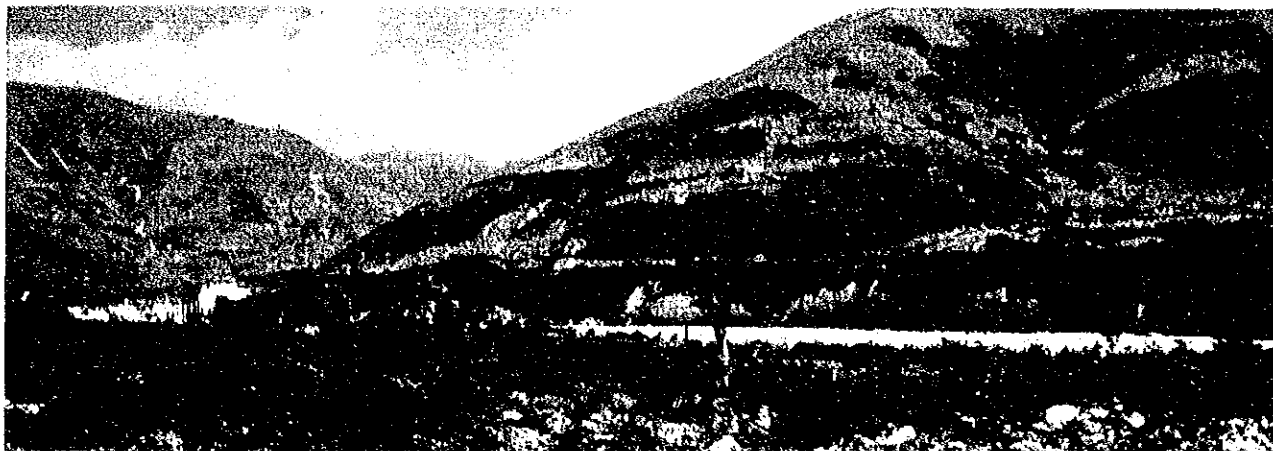
Site prévu de chambre d'eau et de conduite forcée
